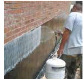
Für eine schnelle, einfache Schaumstoffplatteninstallation sprühen und kleben Sie einfach mit 3M™ HoldFast 70 Sprühklebstoff in Flaschen. Verklebt Schaum auf Beton, Abdichtungen, OSB und mehr, ohne den Schaum zu beschädigen.
