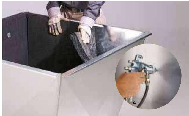
3M Universalklebstoffe werden häufig für die Installation von Reißwolle, Entlüftungsisolierung und anderen Schaumstoffen und Gewebe verwendet. Unsere Produktlinie bietet die größte Vielseitigkeit bei der Klebstoffabgabe. 3M™ Super 77™ Universal-Sprühklebstoff kann z. B. aus Großbehältern, Flaschen oder Aerosoldosen versprüht werden.
